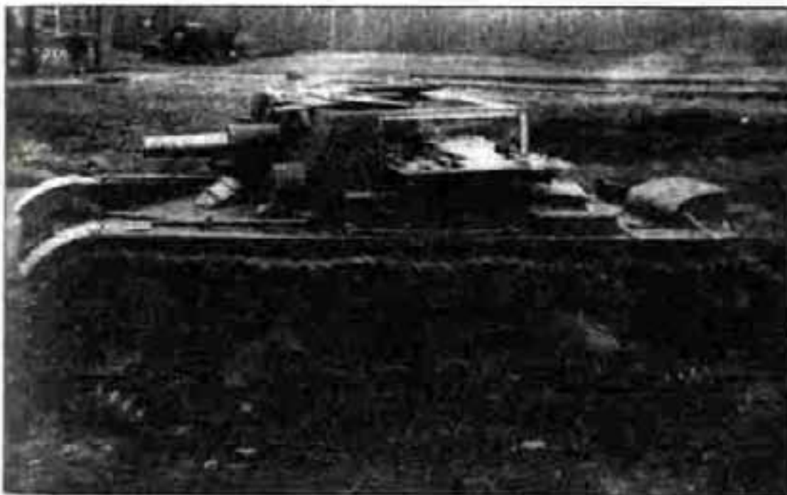
Арттанк АТ-1 с откинутыми бортами рубки для стрельбы с закрытой позиции.
