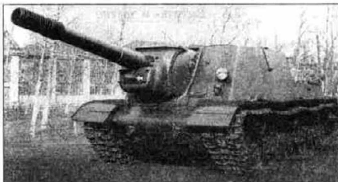
Самоходно-артиллерийская установка ИСУ-152 («Объект 241»). Октябрь 1943 г.
