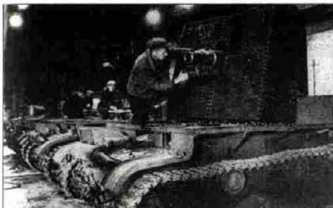
Монтаж вооружения в СУ-26. 1941 г.
