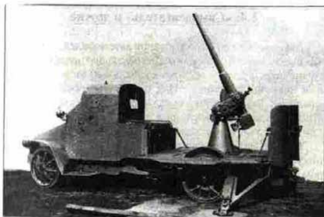
Противозенитная 57-мм пушка Гочкиса на грузовике «Астин», 1915 г.
