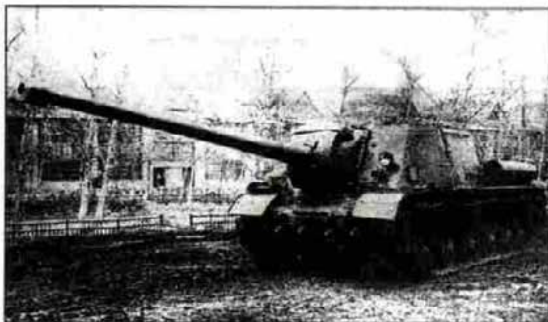
ИСУ-122-3 («Объект 251»), вооруженная 122-мм орудием С-26-1, 1945 г.
