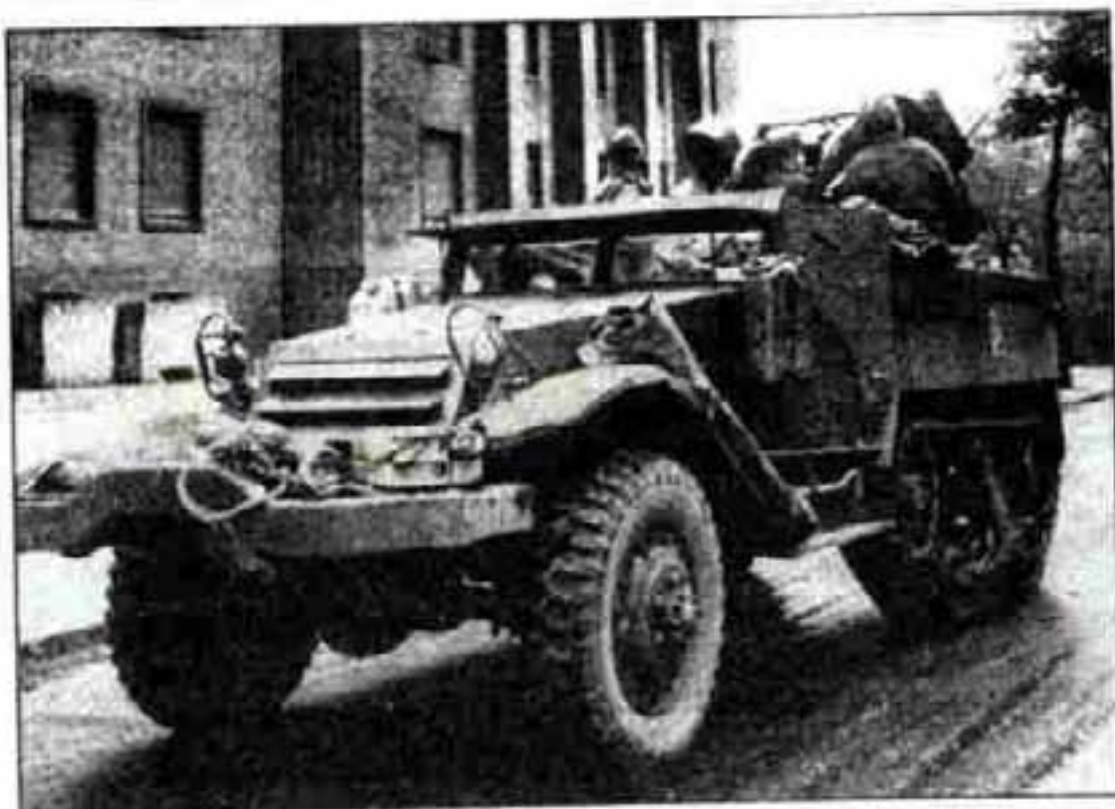
Зенитная САУ М17 на шасси БТР М5 в Берлине. Апрель, 1945 г.
